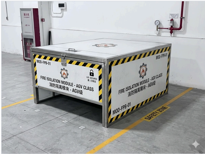
警示涂装与上部开启形式： 罩体正面四周为黄黑警示色带，板面标注模块名与型号、锁定状态；罩顶为带拉手的开启盖。
